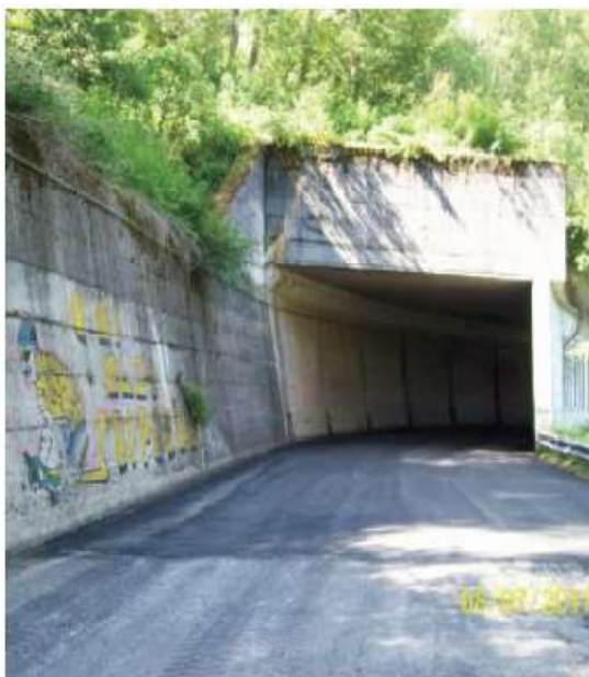
Una delle strade che portano dal fondovalle a Montecampione
